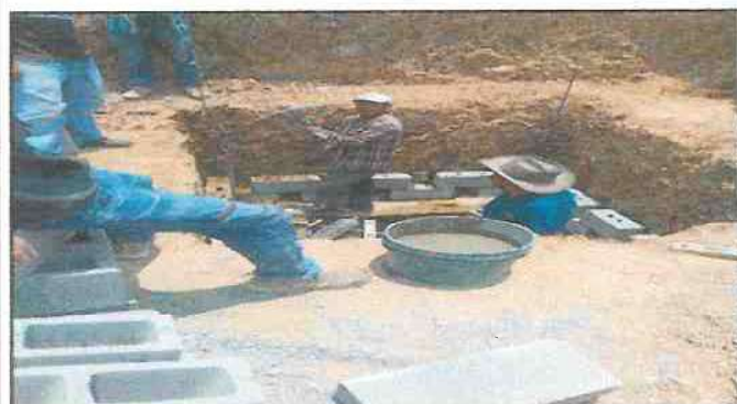
Foto 3: Reparación de sanitarios
