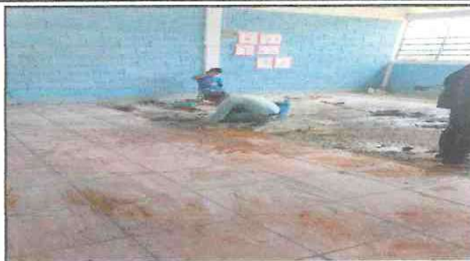
Foto 2: Cambio de piso a cerámica
