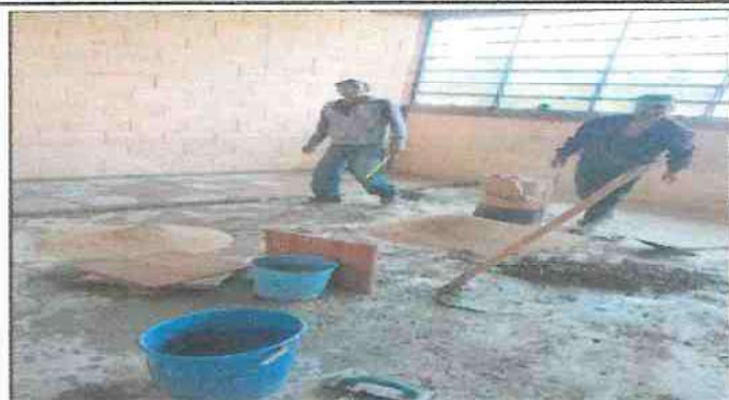
Foto1: Piso en mal estado
